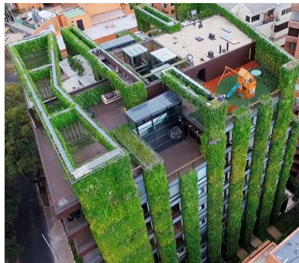
Figura 2. Edificio Santa laila- Bogota
