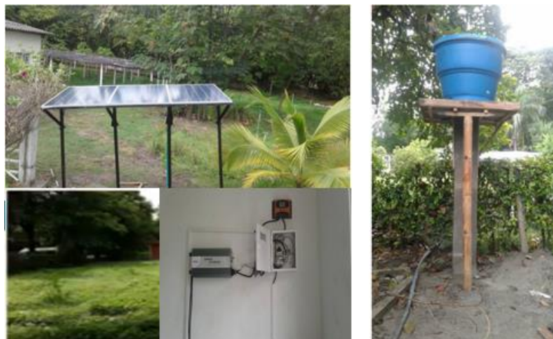
Figura 2. Montaje proyecto fotovoltaico y almacenamiento de agua para abastecimiento a parcela de frutas tropicales. Espinal, Colombia, 2020. Fuente. Elaboración propia.
